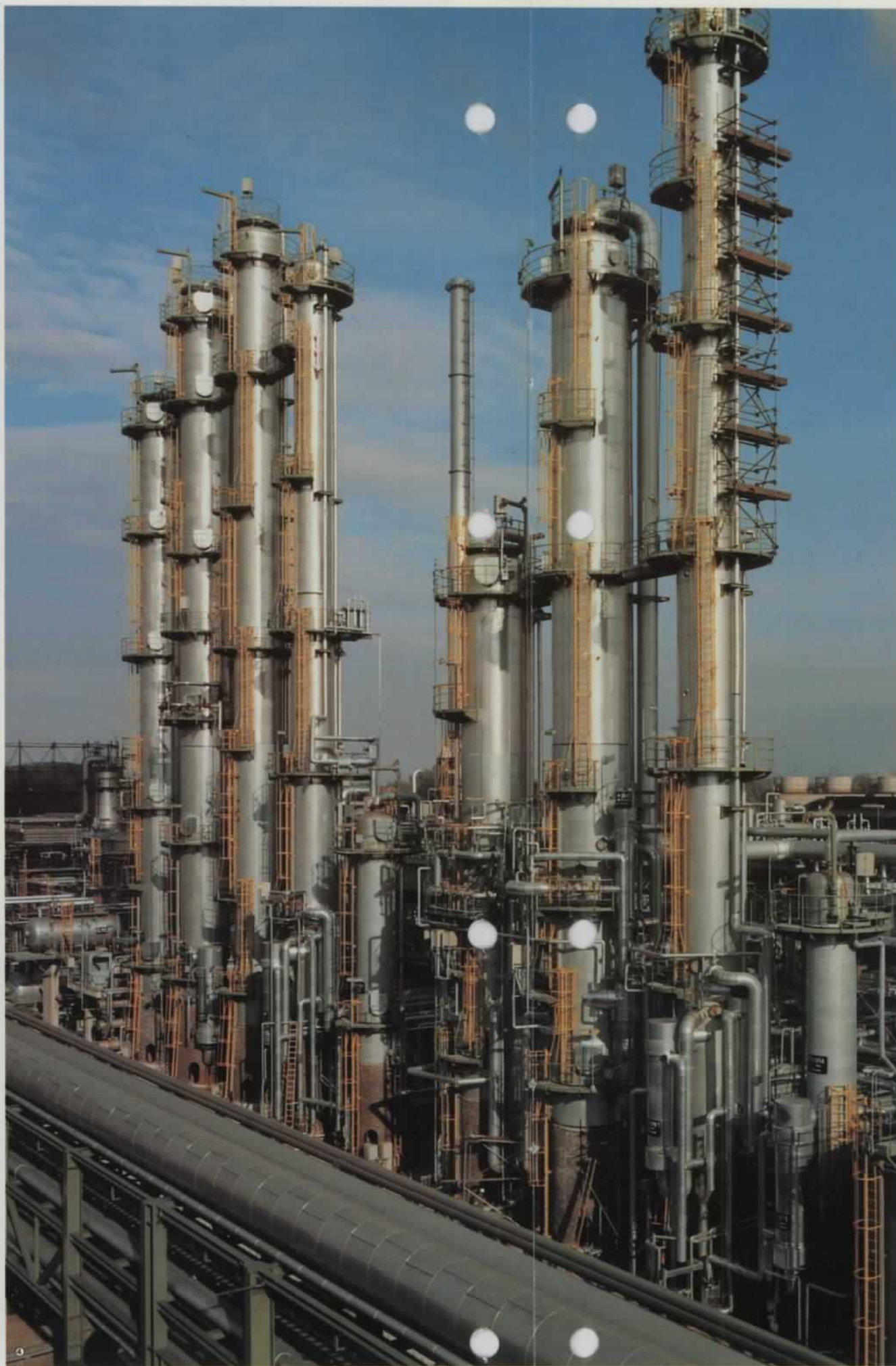
① Anlage zur Gewinnung von Reinbenzol (Morphylane®-Verfahren) ① Plant for the recovery of pure benzene (Morphylane® process) ① Installation pour la récupération de benzène pur (procédé Morphylane®) ② Anlage zur Herstellung von Benzol durch Hydroalkylierung von Pyrolysebenzin ② Plant for the production of benzene by hydroalkylation of pyrolysis gasoline ② Installation pour la production de benzène par hydroalkylation d'essences de pyrolyse
