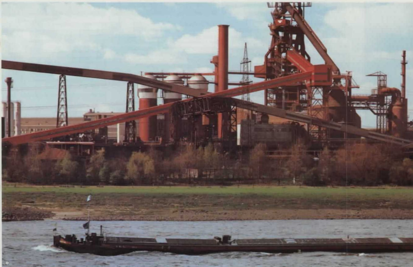
① Hochofen mit Wind- erhitzern, Bauart Krupp Koppers ① Blast furnace with hot blast stoves, Krupp Koppers type ① Haut fourneau avec réchauffeurs de vent, système Krupp Koppers
