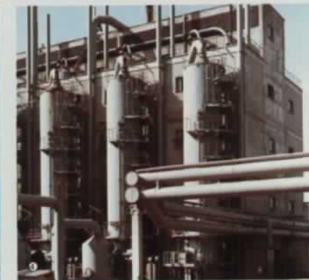
③ Anlage zur Aufbereitung von Rohsynthesegas aus Kohle zu Reinsynthesegas ③ Plant for the processing of raw synthesis gas from coal to pure synthesis gas ③ Installation pour le conditionnement de gaz brut de synthèse à partir du charbon pour l'obtention de gaz pur de synthèse
