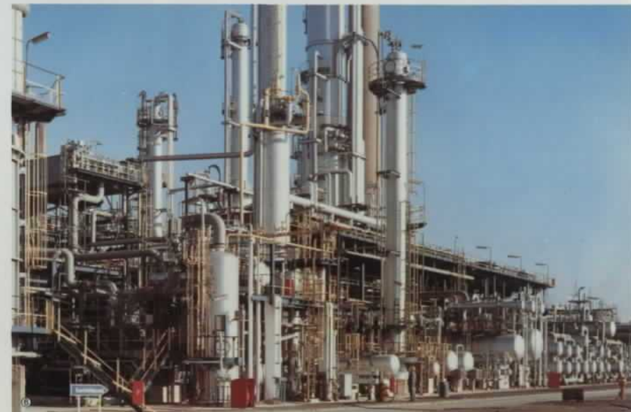
① Anlage zur Gewinnung von Reinbenzol (Morphylane®-Verfahren) ① Plant for the recovery of pure benzene (Morphylane® process) ① Installation pour la récupération de benzène pur (procédé Morphylane®) ② Anlage zur Herstellung von Benzol durch Hydroalkylierung von Pyrolysebenzin ② Plant for the production of benzene by hydroalkylation of pyrolysis gasoline ② Installation pour la production de benzène par hydroalkylation d'essences de pyrolyse
